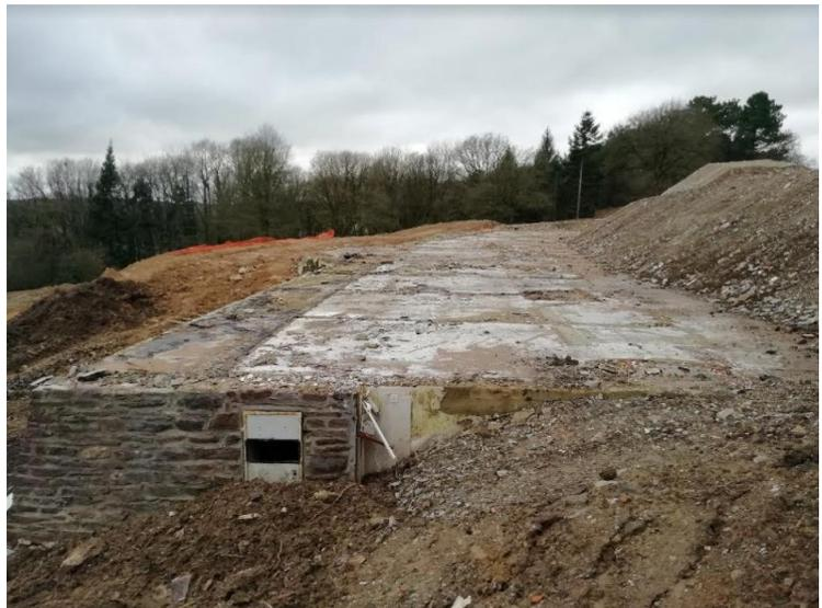
*Figure 16 : Photographie du bâtiment, après démolition de la partie supérieure (Viabilis Aménagement)*
