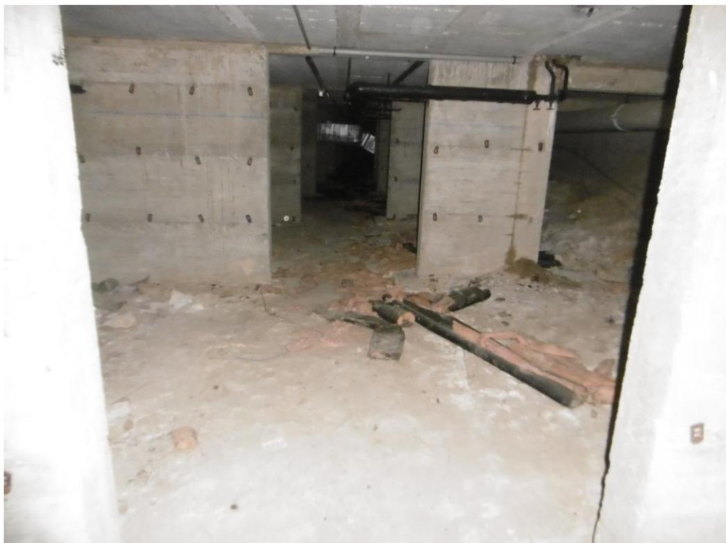
*Figure 8 : Photographie du sous-sol permettant de visualiser les cloisons de soutènement et les parpaings au plafond (IAO SENN, octobre 2019)*
