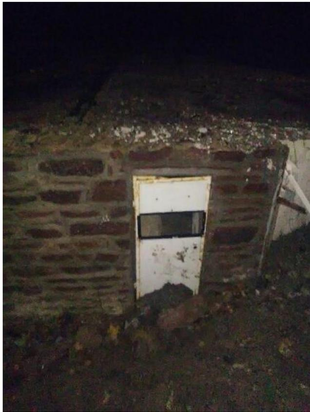
*Figure 17 : Illustration de la porte à l'est aménagée : lucarne + remblais au pied (Viabilis Aménagement)*
